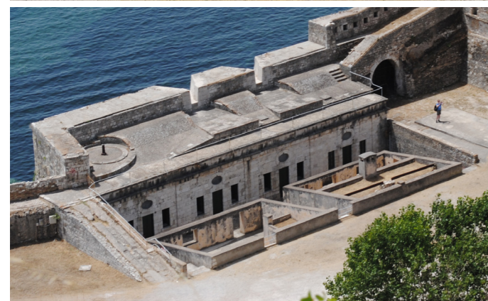
Άποψη του συγκροτήματος από τα βορειοανατολικά.
