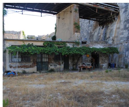
Κτίσματα ανάμεσα στους πυλώνες της γέφυρας.
