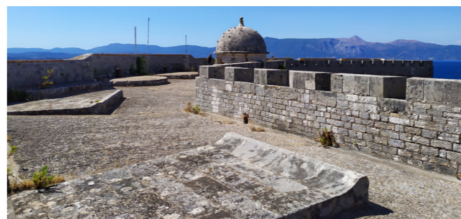
Άποψη του δώματος του κτιρίου.
