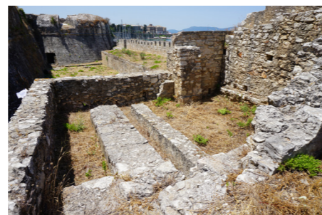
Άποψη δώματος πυριτιδαποθήκης
