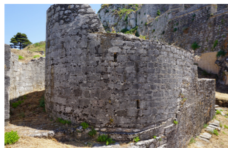
Νότια όψη, ημικυκλικός χώρος πυριτιδαποθήκης
