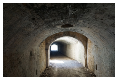
Θολωτή στοά προς Καβοσίδερο, κυκλικός φεγγίτης
