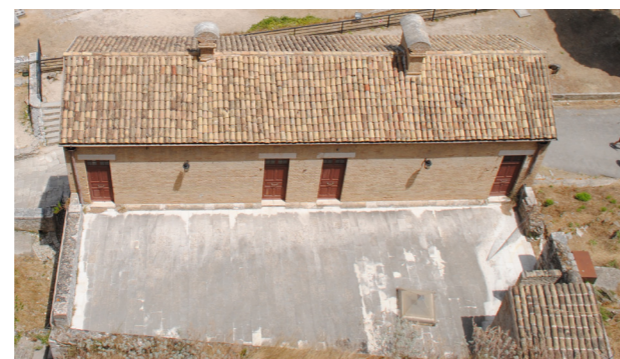
Απόψη του δώματος στο επίπεδο του ορόφου.
