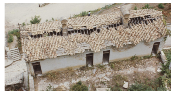
Άποψη από ψηλά το 1992 (Πηγή: Αρχείο ΔΑΒΜΜ)
