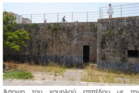
Άποψη του χαμηλού επιπέδου με την κανονιοστοιχία και τις υπόγειες εγκαταστάσεις (πυριπιδαποθήκη και φυλάκιο)
