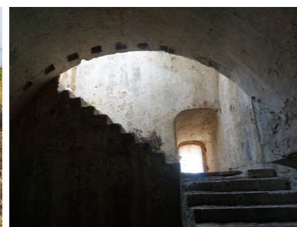
Θολοσκεπές υπόγειο κτίσμα στα νότια.
