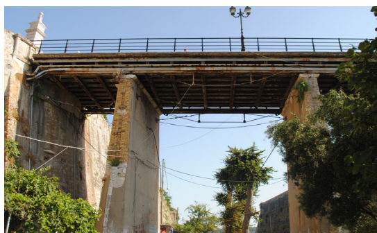
Τα μεταλλικά στοιχεία του καταστρώματος.
