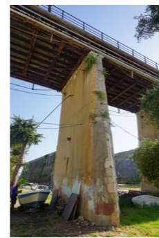
Ο πυλώνας της γέφυρας
