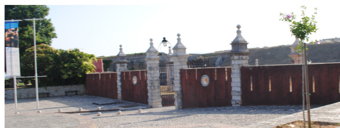
Άποψη της πύλης από τη Σπιανάδα.
