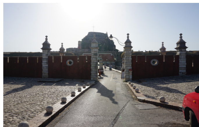
Άποψη της πύλης από τη Σπιανάδα.
