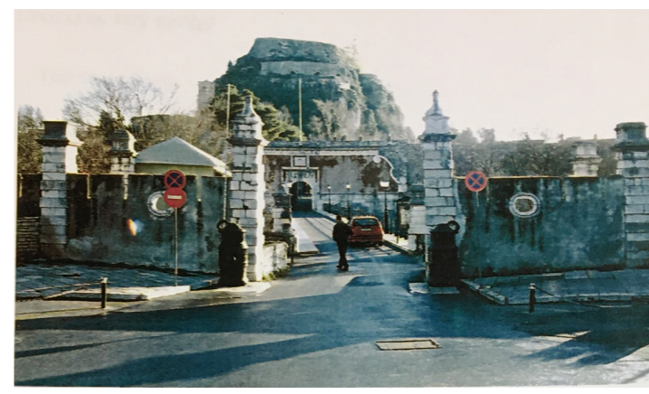
Δυτική όψη, 1997. (Πηγή: Αρχείο ΔΑΒΜΜ)
