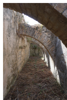
Άποψη του εξωτερικού περιδρόμου με τις μεταγενέστερες αντηρίδες από οπποπλινθοδομή
