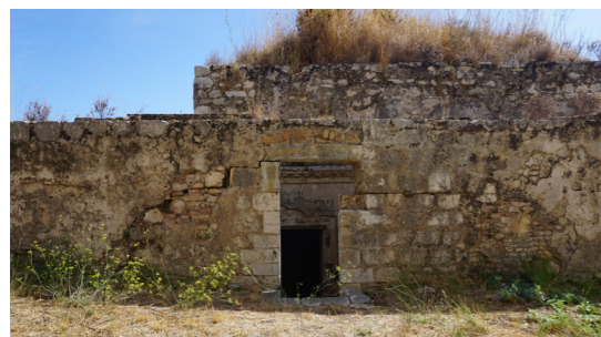
Βόρεια όψη εξωτερικού περιβόλου. Άποψη της εισόδου.
