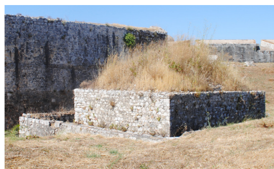
Άποψη από τα νότια.
