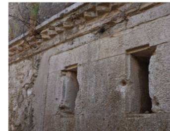
Λεπτομέρεια οπών αερισμού και περιμετρικής οδοντωτής ταινίας.
