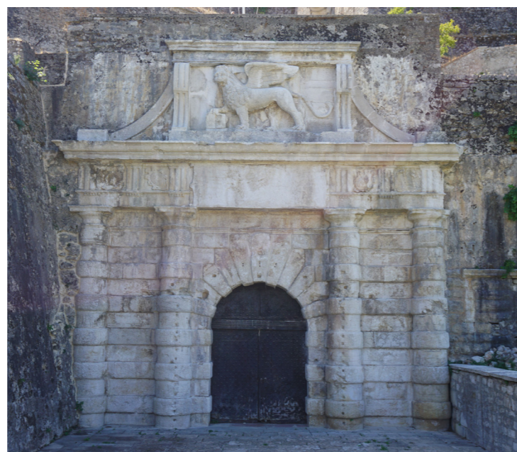
Βόρεια όψη της πύλης (από το δρόμο)
